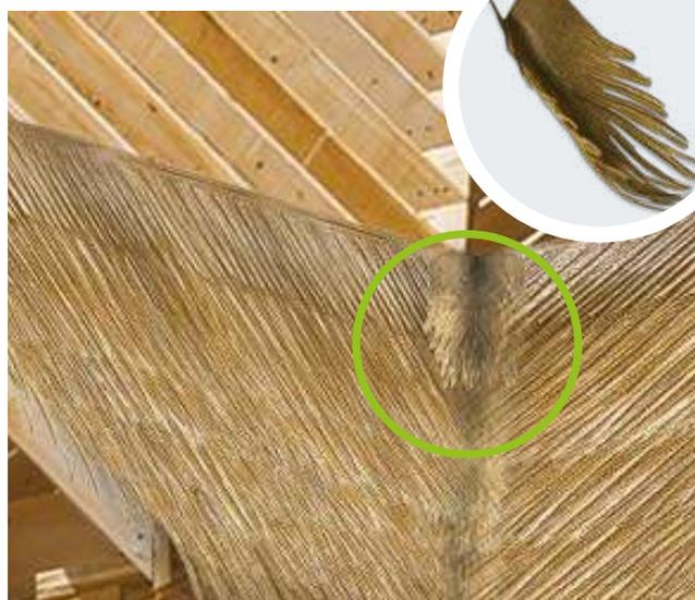
4 À l'intersection entre deux pentes de toit qui forment un V, placez un arêtier pré-moulé ou tout autre protection équivalente sur **chaque rangée**.
