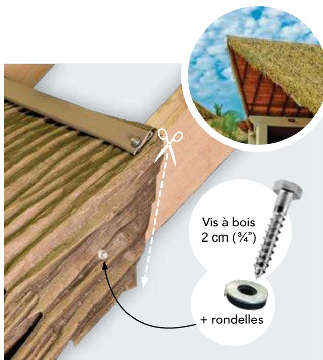
+ Pour la finition des bords latéraux, faites dépasser les feuilles de quelques centimètres/pouces pour pouvoir les replier et les fixer sur le rebord du chevron.
