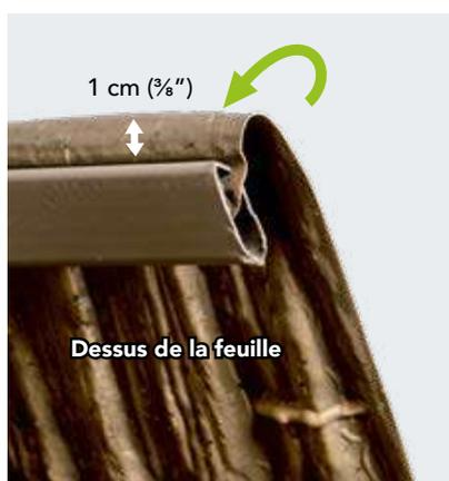
Une fois la feuille insérée dans le rail, repliez le rail vers la feuille de façon à créer un espace de **1 cm** entre le rail et le dessus de la feuille.
