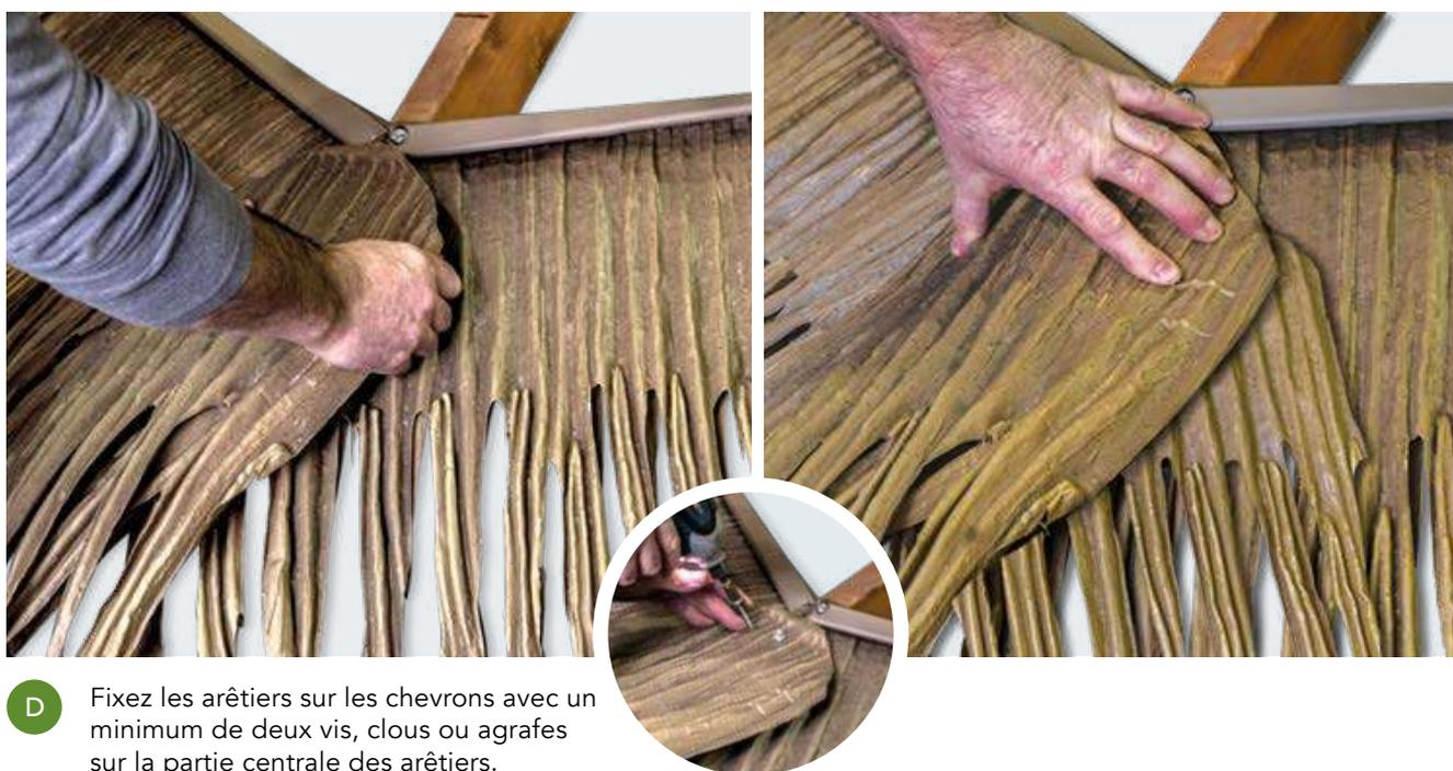
**D** Fixez les arêtiers sur les chevrons avec un minimum de deux vis, clous ou agrafes sur la partie centrale des arêtiers.
