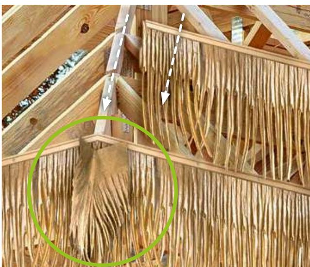
3 Il est important d'entrelacer les folioles des feuilles de toiture de chaque pan avant de placer l'arêtier moulé. Placez l'arêtier moulé **une rangée sur deux** en plaçant les feuilles de toiture de la rangée supérieure par-dessus. Fixez-le sur les chevrons avec un minimum de deux vis, clous ou agrafes.
